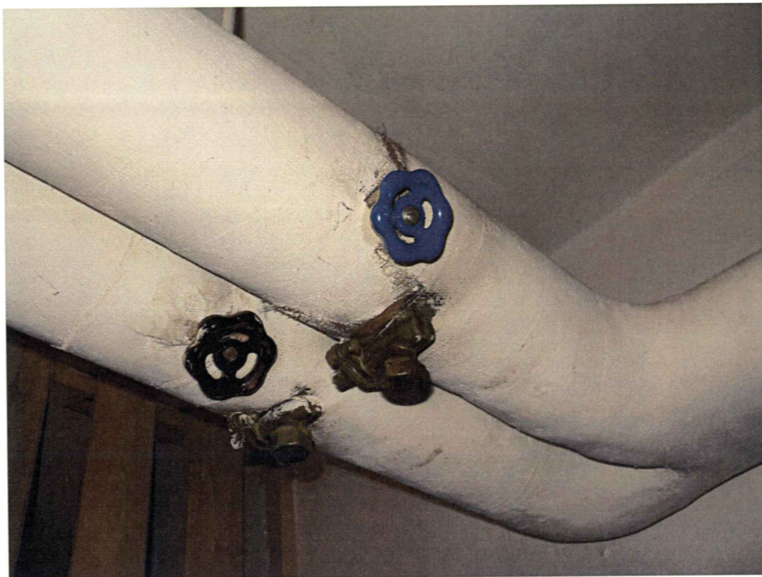
Bild 17 Byte av avstängningsventiler
