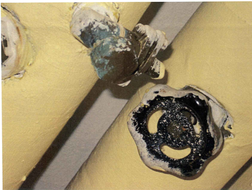
Bild 15 Byte av avstängningsventiler
