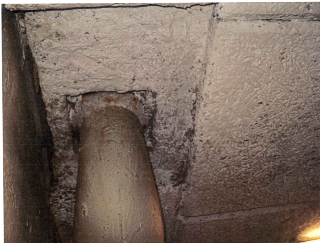
Bild 20 Kontroll av avloppsrör i garagen
