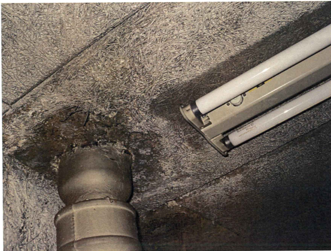
Bild 19 Kontroll av avloppsrör i garagen
