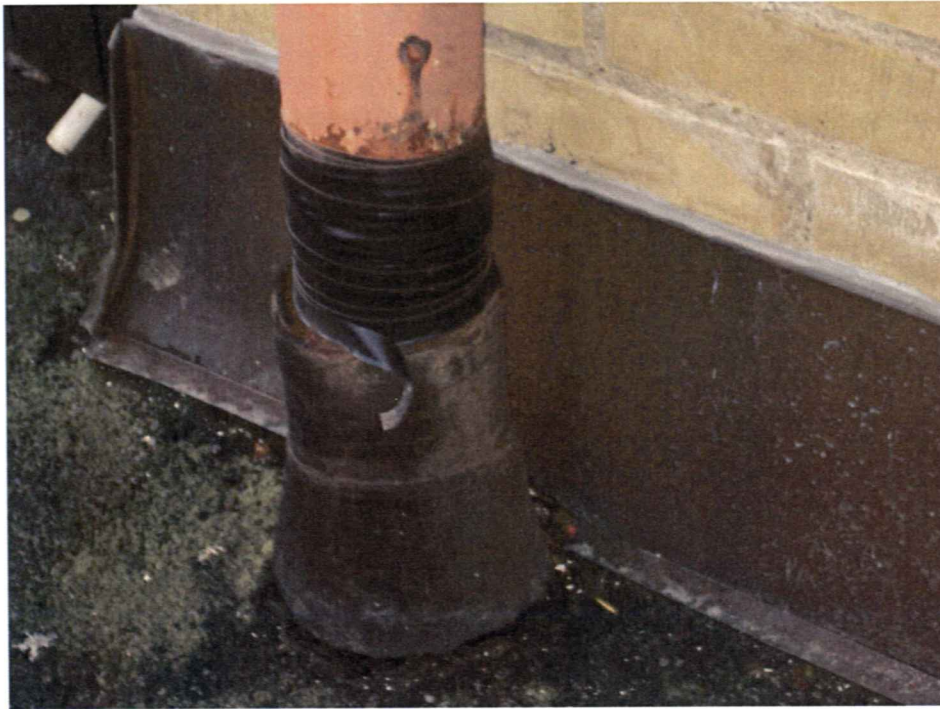
Bild 13 Komplettering av stuprör med rensanordning
