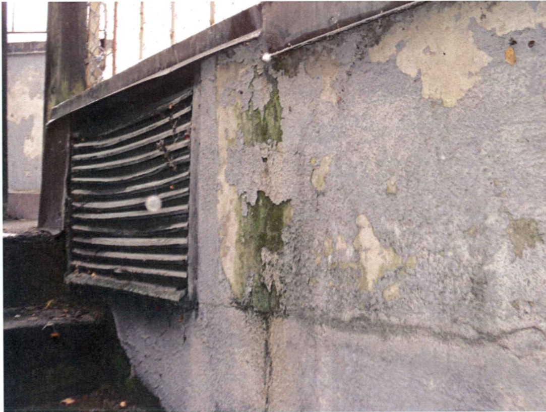
Bild 21 Kontroll av fukt i garagen
