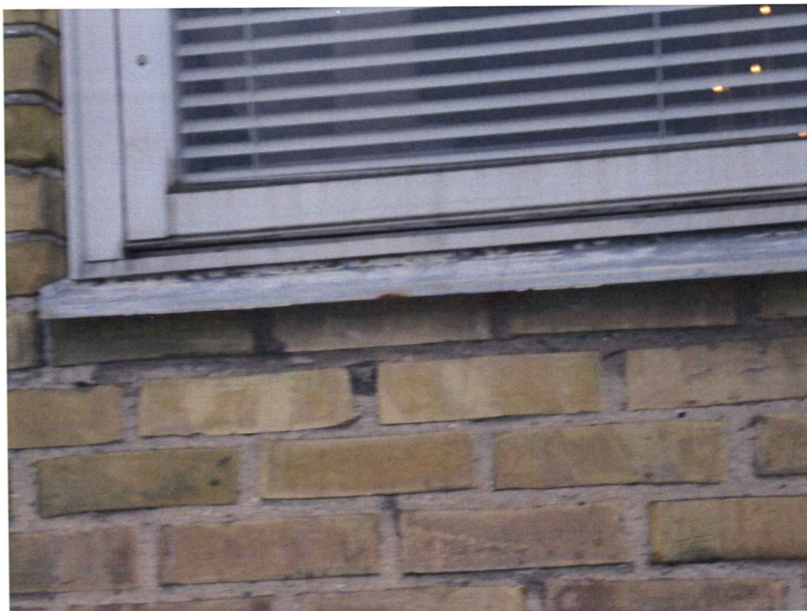
Bild 3 Byte av fönsterbleck
