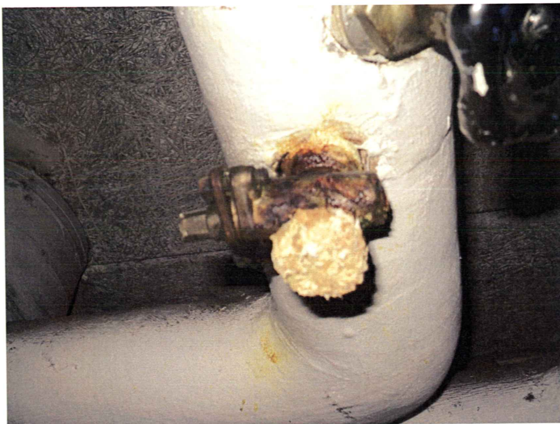
Bild 18 Byte av avstängningsventiler
