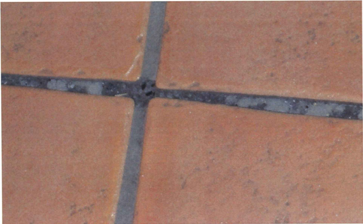
Bild 1 Fogkomplettering av golvet i tokrum
