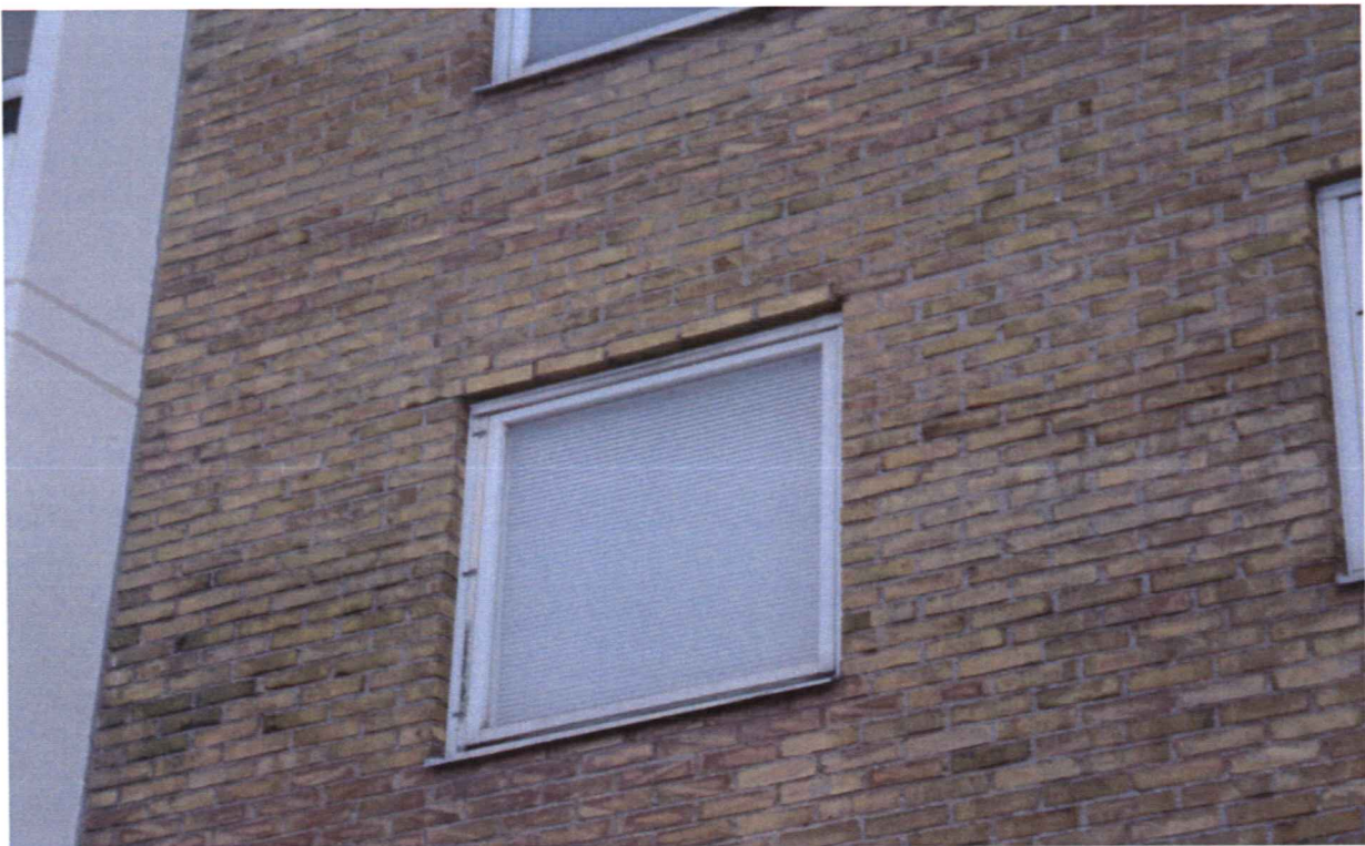
Bild 2 Byte av fönsterbalk ovan fönster
