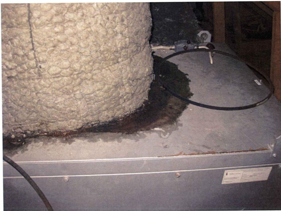
Bild 23 Kontroll av ventilationsinstallationer
