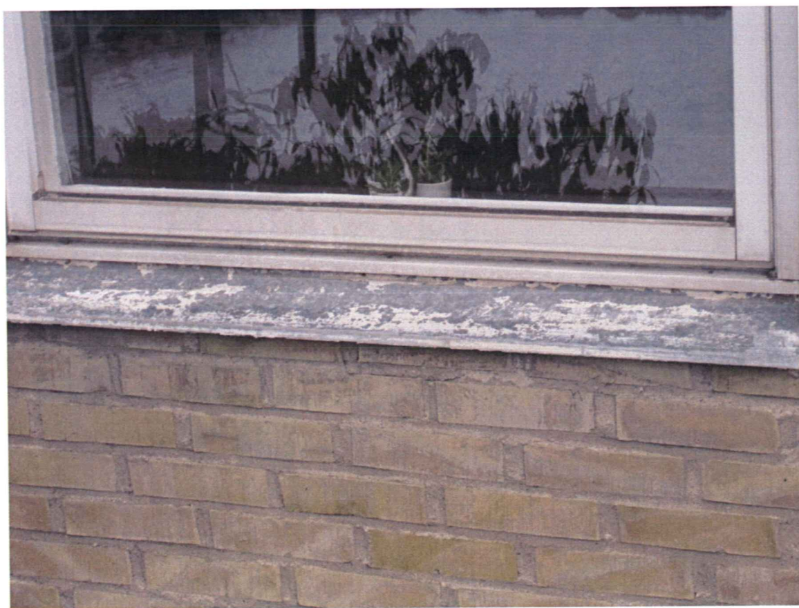
Bild 4 Byte av fönsterbleck
