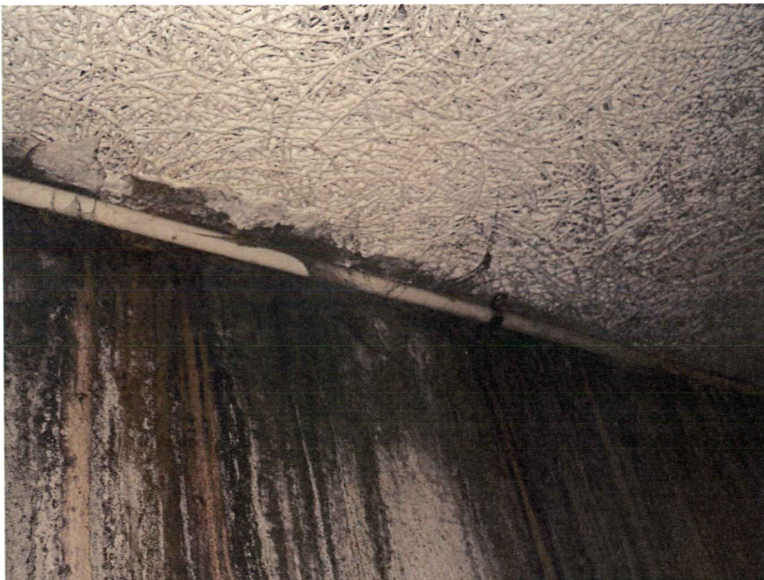
Bild 22 Kontroll av fukt i garagen
