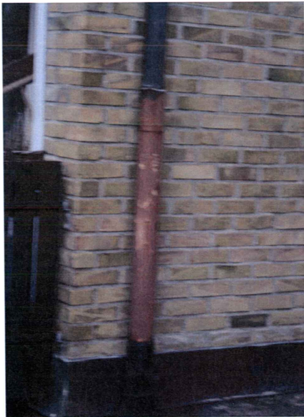
Bild 14 Komplettering av stuprör med rensanordning
